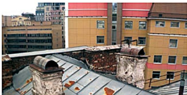
**Фото 2.** Антенны на оголовке создают препятствие для выхода отработанного воздуха, способствуют возникновению обратной тяги, разрушают оголовки.
