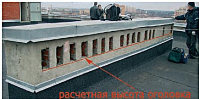
**Фото 6.** Вид оголовков в девяти- и двенадцатиэтажных домах распространенной серии II-18. Вентиляционные каналы в этих домах обслуживать невозможно из-за их конструкции. В кухнях установлены газовые плиты.
