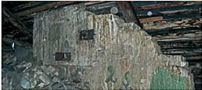
**Фото 4.** У этих оголовков два недостатка: 1 — размещение в зоне ветрового подпора, 2 — накрыты плитами, не обеспечивающими сквозное проветривание.
